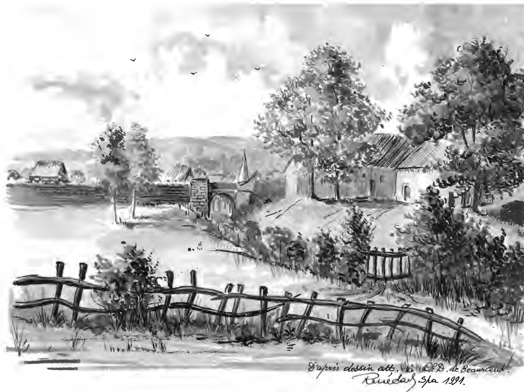
6) Porte de Stavelot (vue prise de la Place des Ecoles). De g. à dr. : le mur, la porte de Stavelot, l'église (dans le fond).
